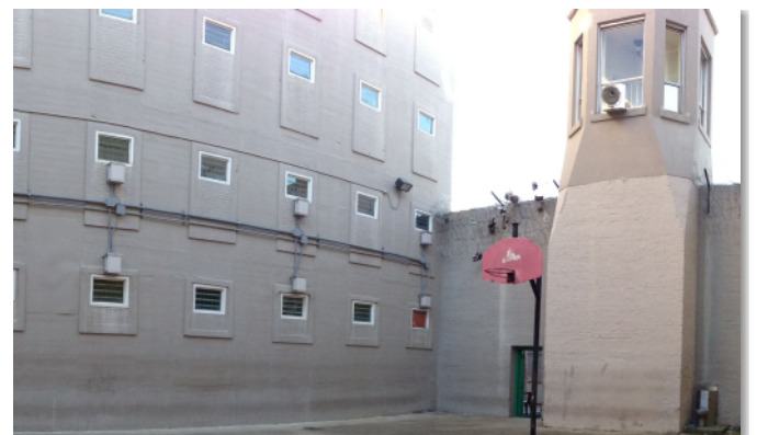
Abb.: Außeninstallation am Orleans Parish Prison, New Orleans (USA)
